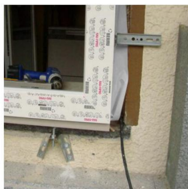
Renowacja z zastosowaniem konsol
