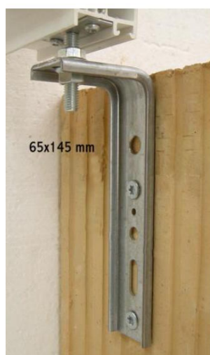
Konsole FMW z łącznikiem płaskim
