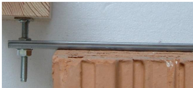
Ilustracja 17: Konsola WM poniżej okna drewniane
