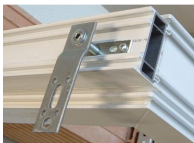
Ilustracja 44: Wstępnie wykonać wstępne otwory w oknie i założyć element regulacyjny
