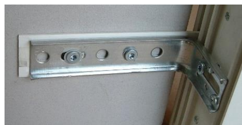
Ilustracja 79: FMW z ISO-Platte zamontowane
