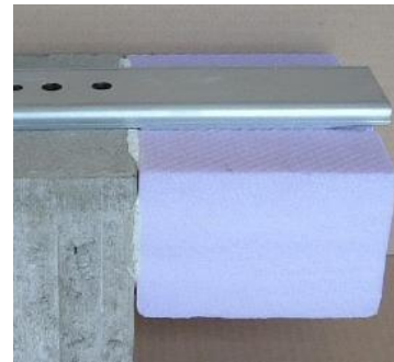
Ilustracja 59: Wprowadzić i zamocować wspornik (podtawki muszą przylegać do płyty betonowej)
