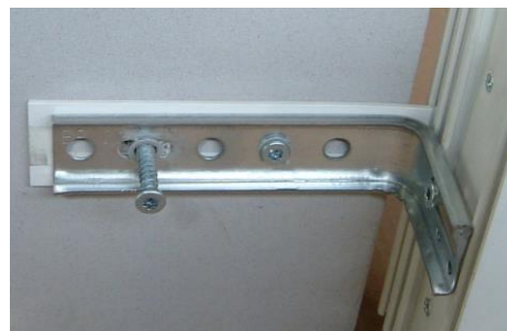
Ilustracja 82: Krok 2 - przymocować cokołami najmiej dwoma punktami mocującymi do muru.
