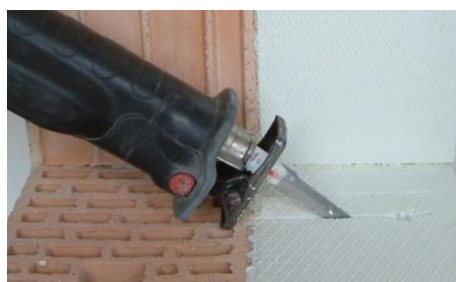
Ilustracja 42: Precyzyjnie wykonać pozycję zamocowania, wprowadzić konsolę SL i zamocować
