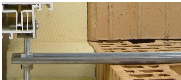
Ilustracja 16: Konsola WU poniżej okna z plastiku
