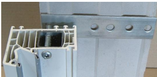
Ilustracja 12: Krok 2 - przykręcić przez futrynę okienną
