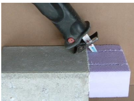
Ilustracja 58: Precyzyjnie wyciąć pozycję zamocowania
