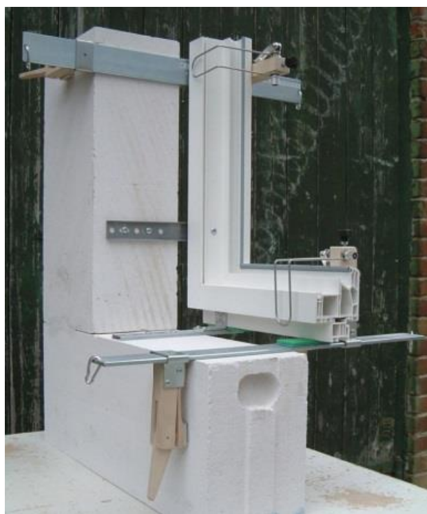
Ilustracja 126: Montaż okna przy użyciu zacisków śrubowych do montażu okna
