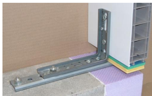
Ilustracja 55: Przykręcanie kątownika
