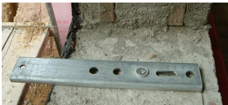
Ilustracja 3: Konsola EL jako pomoc montażowa
