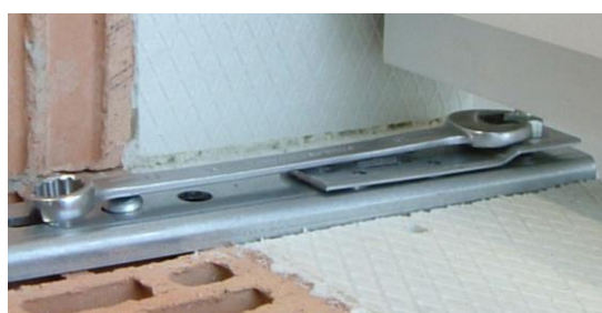
Ilustracja 45: Wyrownać okno na wysokość i
