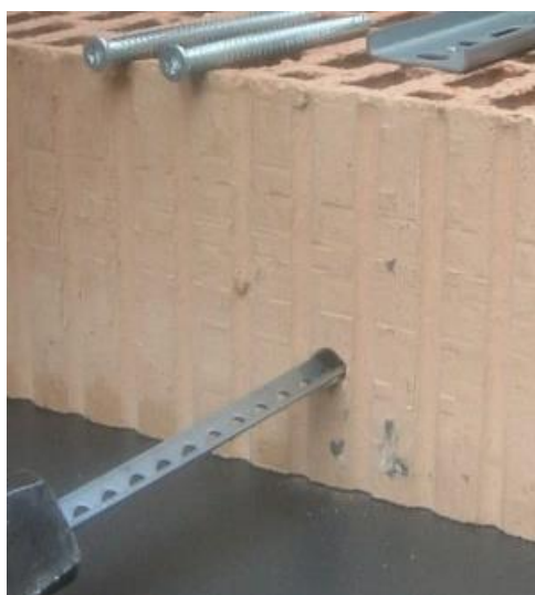
Ilustracja 29: Krok 1 – Wbić szynę perforowaną w wywiercony otwór
