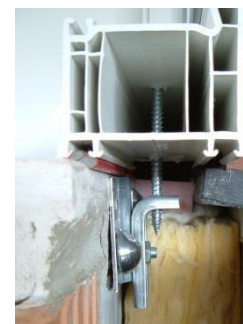
Ilustracja 88: Dolne zamocowanie kątownika
