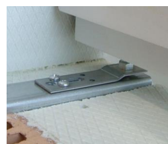
Ilustracja 46: Skręcić element regulacyjny z konsolą SL
