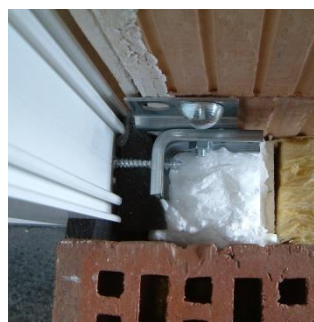
Ilustracja 87: Boczne zamocowanie kątownika
