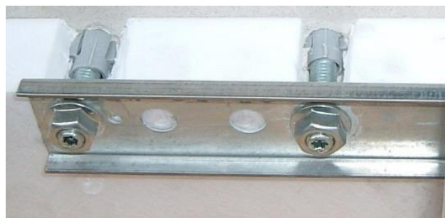
Ilustracja 133: Konsola EL z izolowanym słupem
