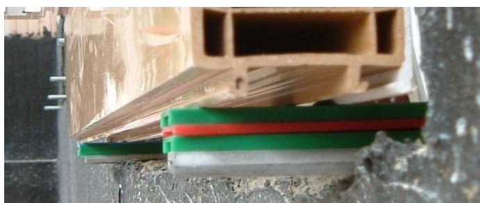
Ilustracja 4: Przykręcenie od dołu przez konsolę
