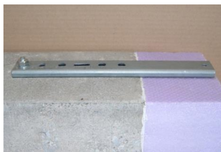
Ilustracja 53: Przywiązanie do betonowej podłogi
